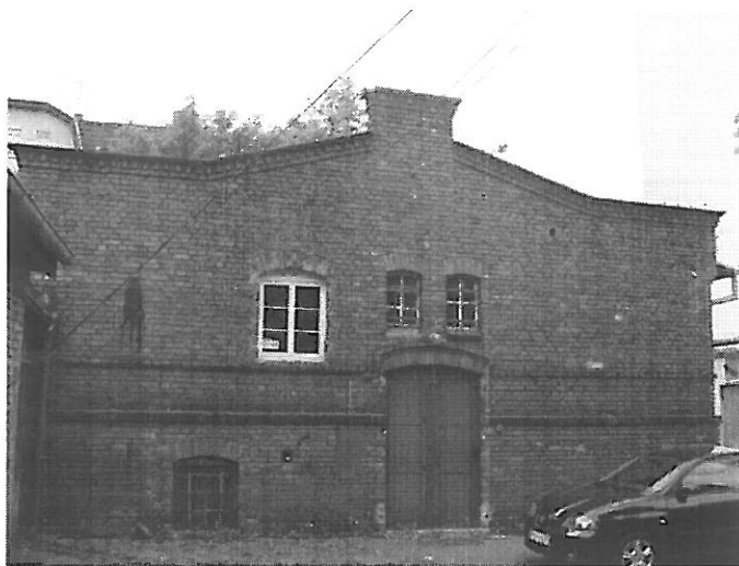
Elewacja północna budynku głównego.
