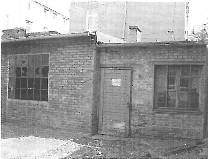
Zabudowania parterowe, część południowa.
