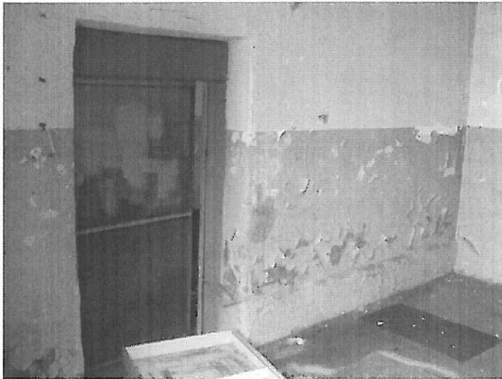
Przykładowy stan wnętrza budynków.
