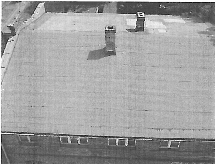
Widok dachu budynku głównego (podpiwniczonego).
