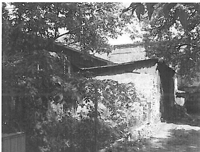
Elewacja wschodnia, widok z ulicy Mazowieckiej.
