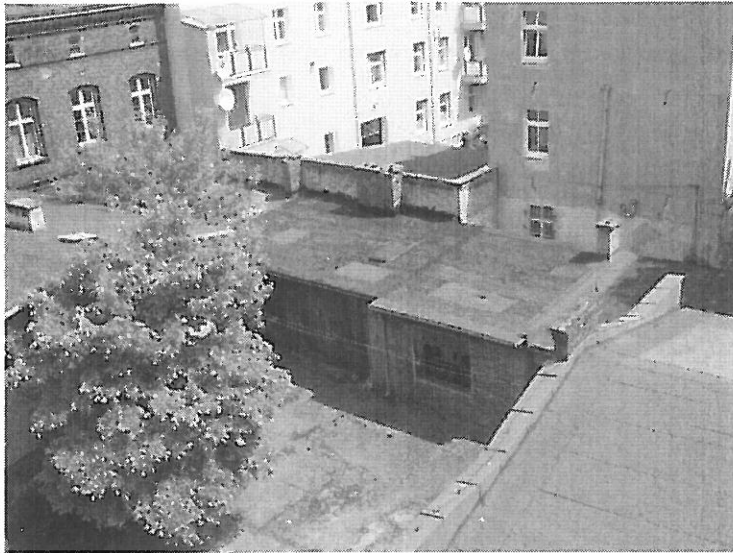
Widok ogólny zabudowań parterowych.
